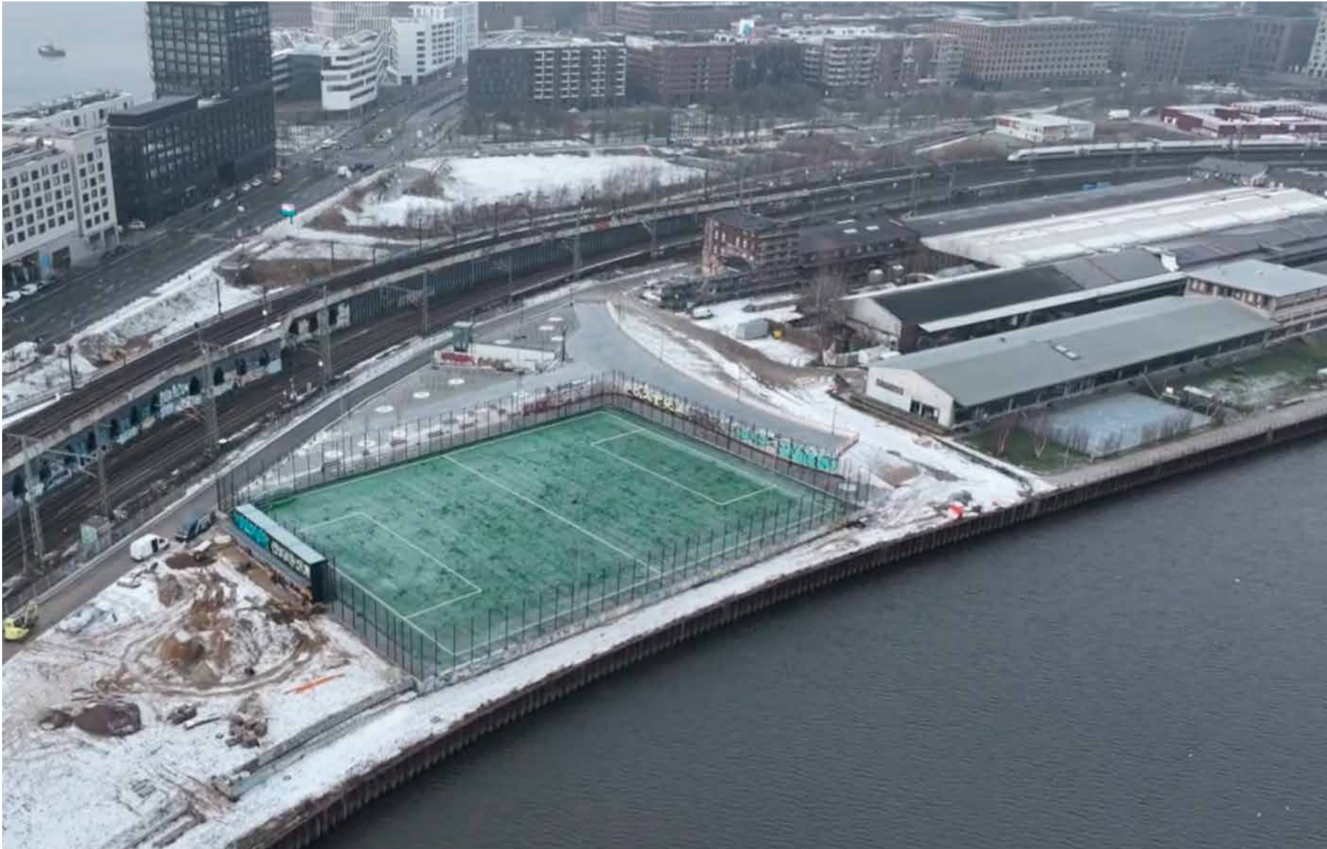
↑ Der neue Sportplatz im Bau Anfang 2025 zwischen Oberhafenkanal und Bahngleisen. © André Dekker
